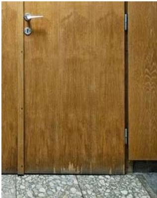
Abb. 170 | Türverkleidung mit Gebrauchsspuren und Verfärbungen, 2024
