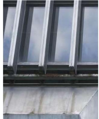
Abb. 167-168 | Korrosionsschäden an der Vorhangfassade, 2024
