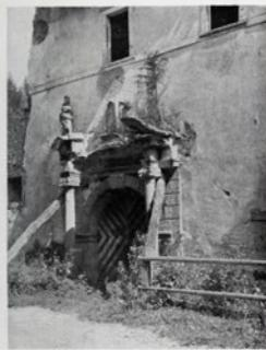
Abb. 14. Portal des einstigen Klosters Seitz bei Gerasnitz in Steiermark im Jahre 1913. Beispiel eines romanisierenden alten Baues. Das schöne Bausportal hat die Mittel- und rechte Seitenstütze verloren, es ist erweitert und durch Vegetation auseinandergerissen, dem Ein- sturz nahe und überdies durch raschidirekten Eisenreich verunstaltet.
