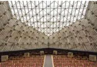
Abb. 93 | KIPSZER-Rasterstruktur der Reformierten Kirche von Kelenföld, Budapest auf. Die von der Firma Könnyűipari Szerelő- és Építő Vállalat hergestellte sog. KIPSZER-Rasterstruktur ist das Erbe der Pavillon- und Hallenarchitektur. Sie wurde ursprünglich für den Bau der HUNGEXPO in Budapest auf der Grundlage des Patents von István Szabó entwickelt. (Pesti, 2020.)
