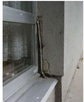
Abb. 169 | Abgelöster Putz im Anschlussbereich von Fenster und Fassade, 2024
