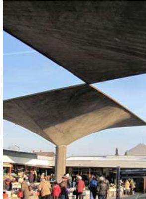
Abb. 73 | Stahlbetonschirme der ehem. Markthalle, 2012
