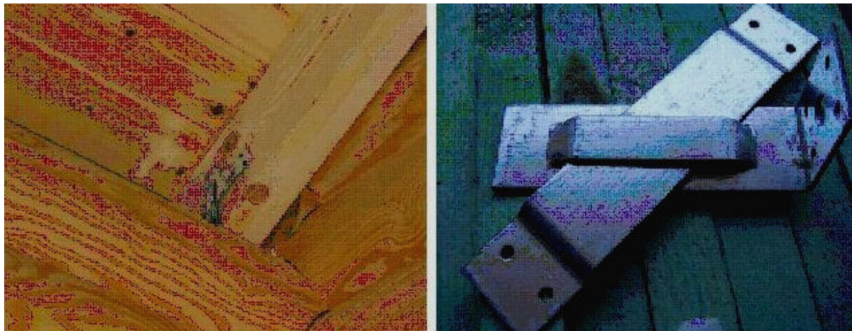
12. ábra – A szelemenek elmozdulását lehetővé tevő csúszzóvasalatok
