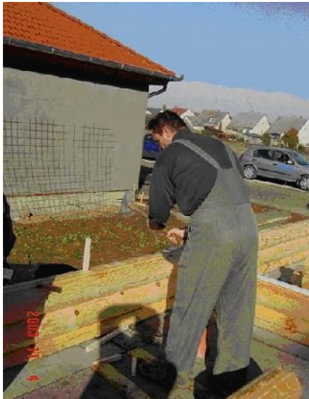
7. ábra – A rönkfal merevítése fa csapokkal történik
