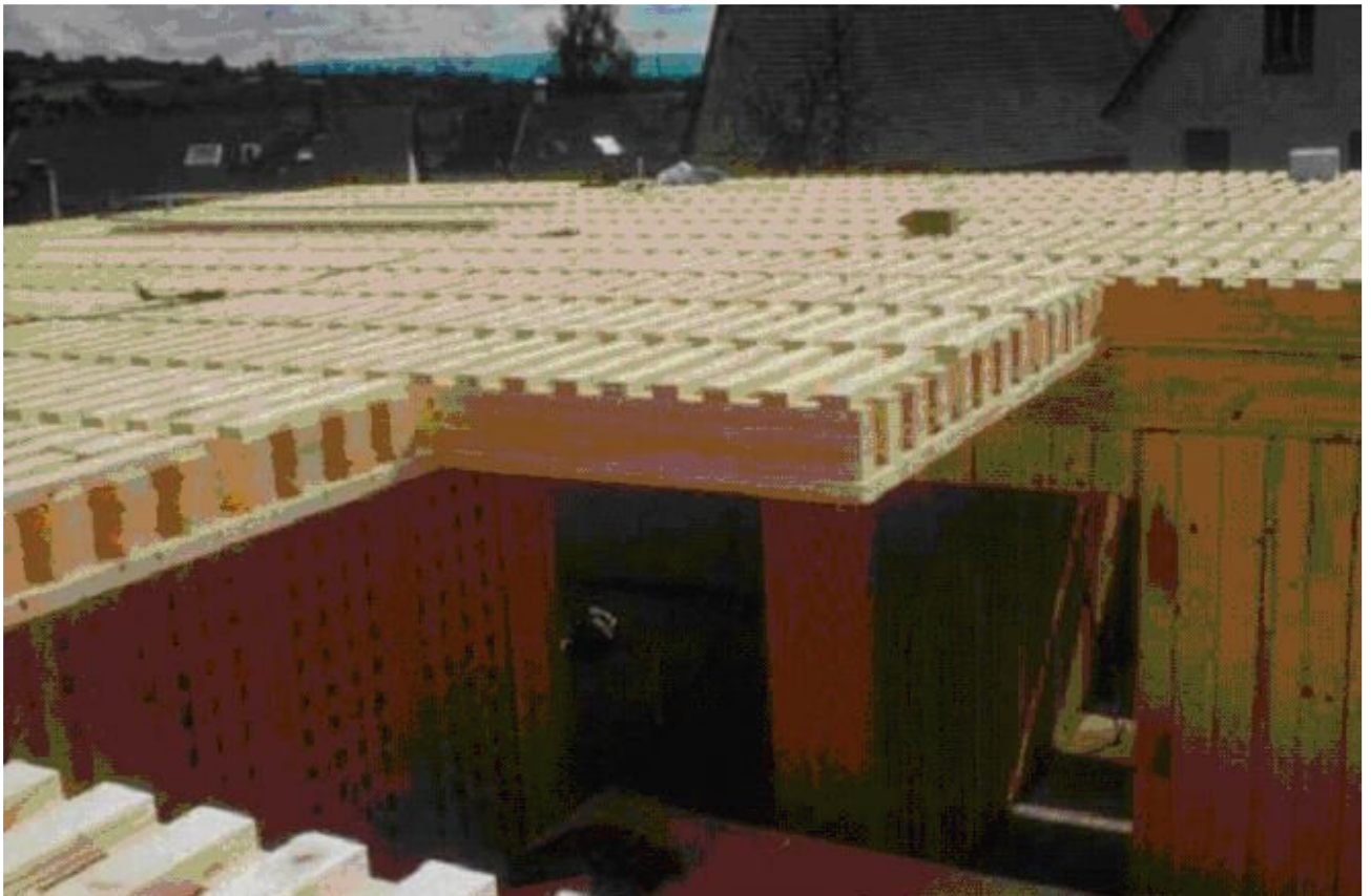
2. ábra – Üreges tömörfa panelekkel készült épület (Forrás: Lignotrend GMBH, http://www.lignotrend.com/)
