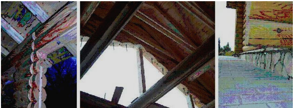
8. ábra – Az áthidalók és alá nem támasztott falrészek összefogása csavarozással
