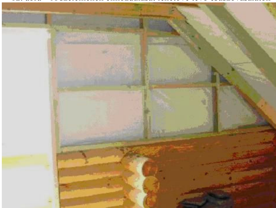
13. ábra – Összetett tetőidomok esetében keretszerkezetes oromfalat alkalmaznak
