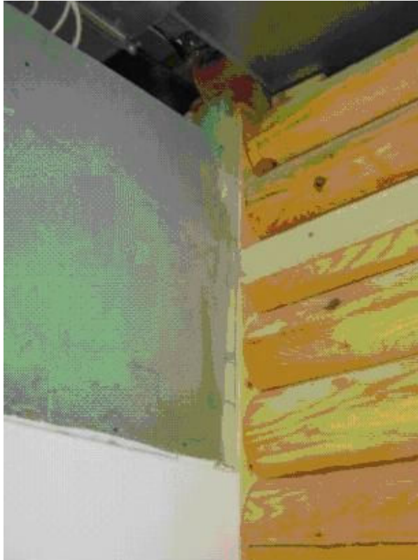
14. ábra – Keretszerkezetes válaszfal csatlakozása a rönkfallal
