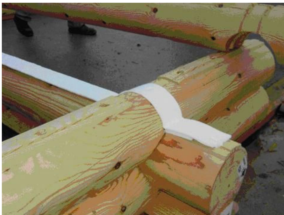
6. ábra – A rönkök között a légzárást tömítőfilc biztosítja
