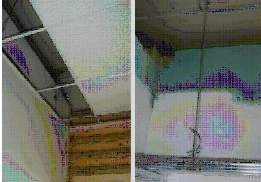
16. ábra – Az álmennyezet rögzítése
