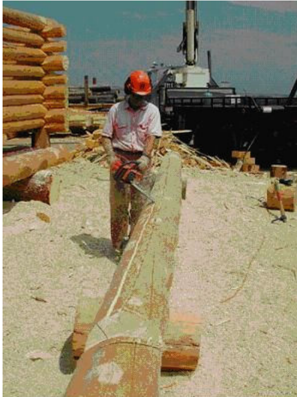
21. ábra – A rönkprofil kialakítása láncfűrész segítségével
