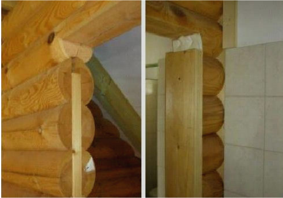
10. ábra – Az ajtótokok beépítéséhez alkalmazott megoldás
