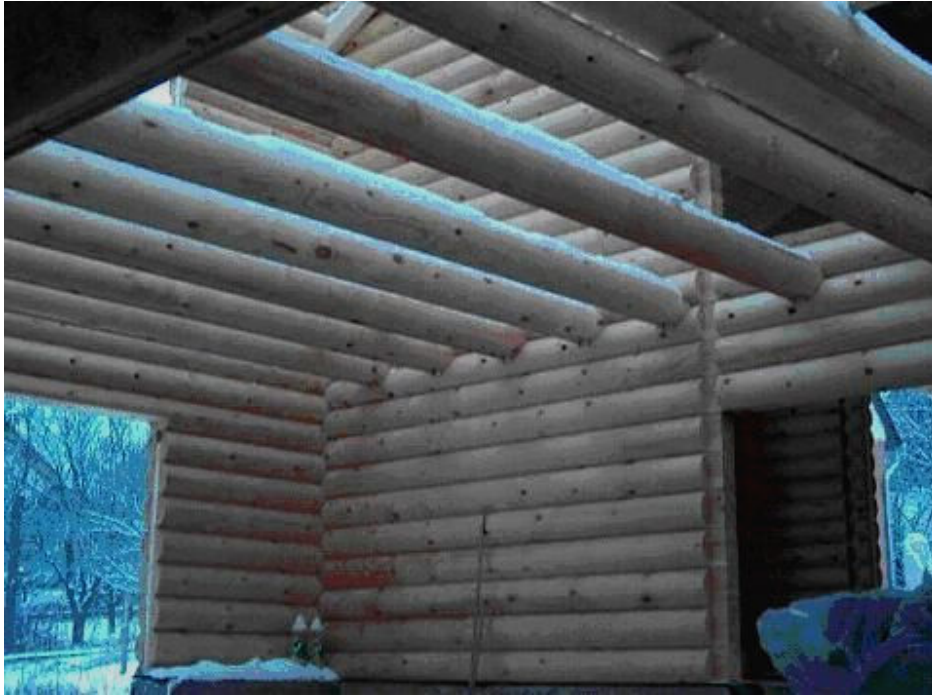
9. ábra – Födémként alkalmazott rönkök
