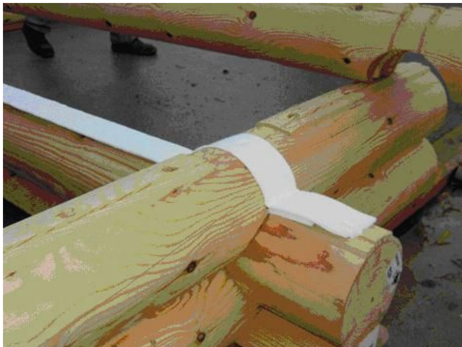
5. ábra – Tömítőfilc alkalmazása a rönkházaknál
