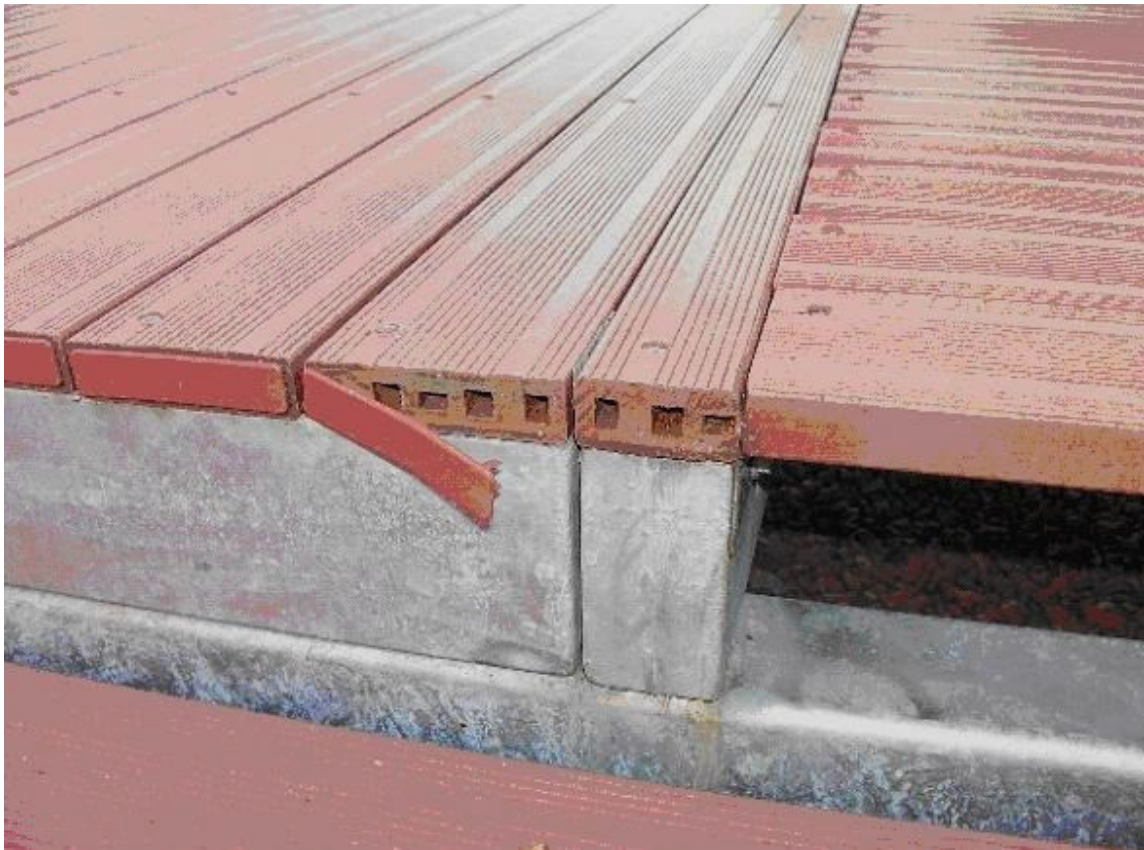
3. ábra – MDF fődémelemek (Bill Bradley fényképe)
